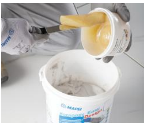
Verser le durcisseur (composant B) dans le bidon du composant A
